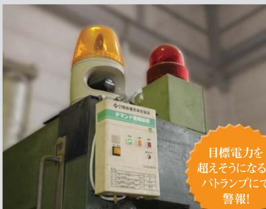
平成18年2月にデマンド監視システムを導入し、導入時には約980kWであった最大デマンドが約930kWまで低下しました。デマンド監視システムは電気使用量を24時間モニターし、目標値を超過しそうになると警報が鳴るもので、当社では警報器を事務所に1カ所、工場に2カ所設置しています。工場は作業音を考慮しパトランプ(回転灯)でも警報を知らせており、警報が鳴った場合はまず空調を停止し、工場も差し支えない工程については止めるなど、従業員の積極的な節電行動につながっています。
