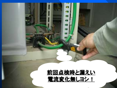
変圧器2次側B種線による 漏れ電流の測定
