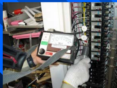
絶縁抵抗計による 回路の絶縁状態の確認
