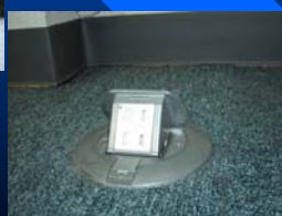
各高圧機器、低圧機器、配線など 目視点検を実施。
