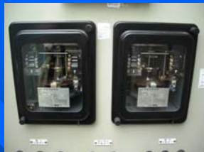
過電流継電器(高圧のショート検出)
