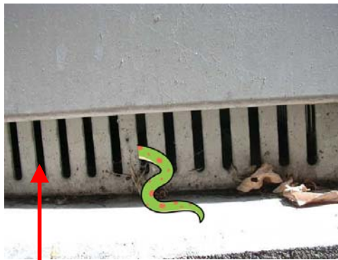
キュービクル基礎部分(小判型換気口)
