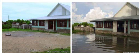
(浸水前) (浸水後) ツバル・フナフチ島における浸水被害 (2002年5月撮影)
