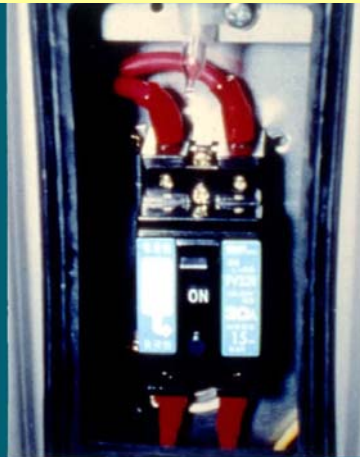
電気温水器の漏電遮断器
