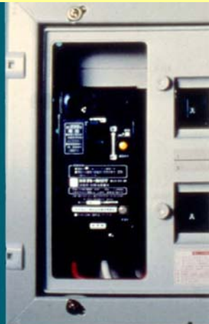
分電盤内の漏電遮断器
