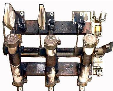
保護装置が動作して、受電設備の高圧開閉器を開放し、工場全体が停電します。
