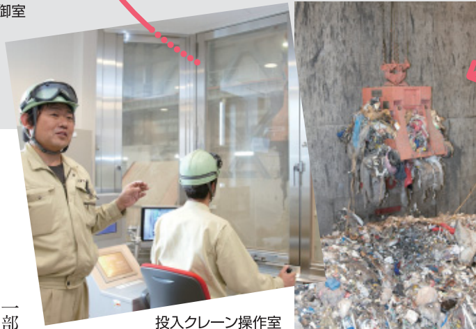
投入クレーン操作室
