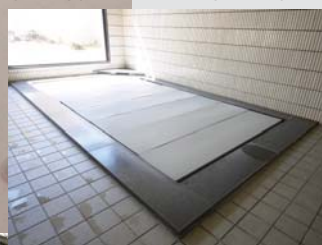
〈写真①〉保温フィルム(大浴場)
