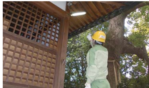
電気の特別点検の風景(平成24年度)
