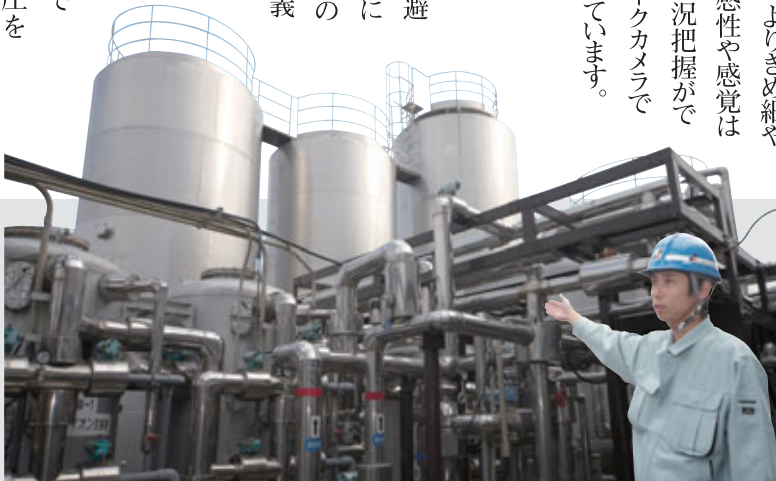
高野山麓の地下水を原料水に生成するタンク類。
