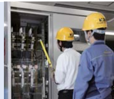
キュービクルのLBS投入 の操作風景
