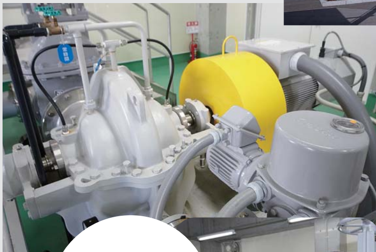
両吸い込み逆転ポンプ水車と発電機
