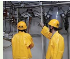
断路器投入の操作風景
