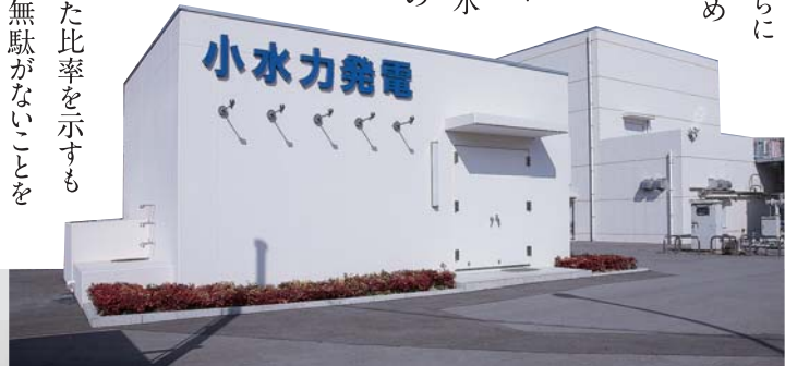
山崎浄水場の小水力発電施設
