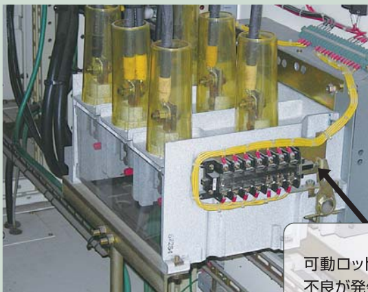
写真2 VCB側面の可動ロッド
