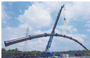
水道管の耐震化工事の様子
