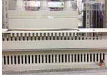
写真5 キュービクル下部の通気孔
