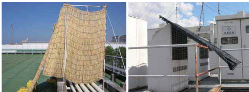
空調機に「よしず」設置例
