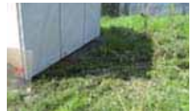
写真2 虫の発生要因となるキュービクル周辺の状況
