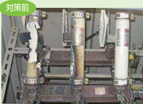
写真11 相間側面バリアがないために機器の焼損に発展
