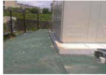
写真4 キュービクル周囲の防草シートの使用例
