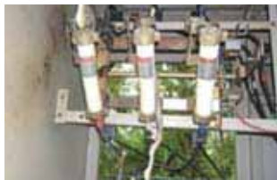
写真1 高圧負荷開閉器に接触し高圧停電事故原因になったヘビ
