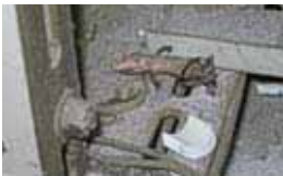
写真3 高圧機器に接触したヤモリ
