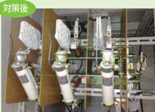
写真12 相間側面バリアを設置
