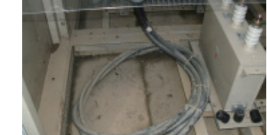
写真2 水害の影響で水没したキュービクル内部
