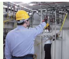
電気室での断路器投入の 操作風景
