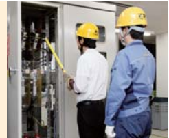
主遮断器操作の実習風景
