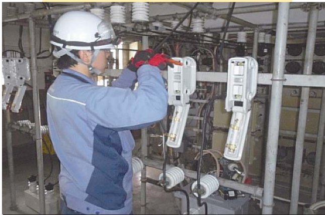
経年劣化したプライマリーカットアウトスイッチの交換工事
