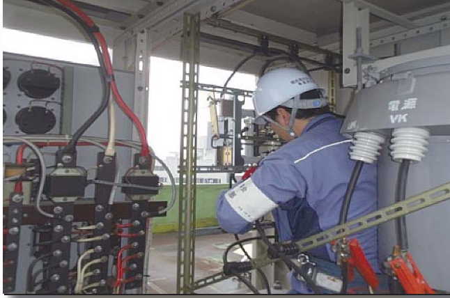
経年劣化した計器用変成器の交換工事
