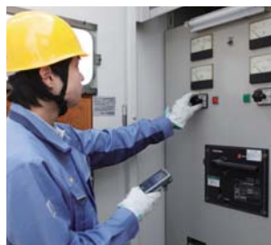
キュービクルの電圧・電流計測
