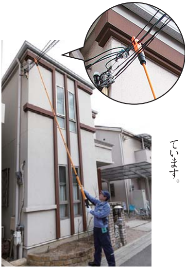
手で測定できない電気設備の漏れ電流の測定
