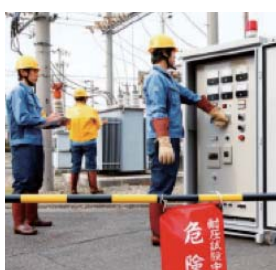
大規模な特別高圧設備の絶縁耐力試験
