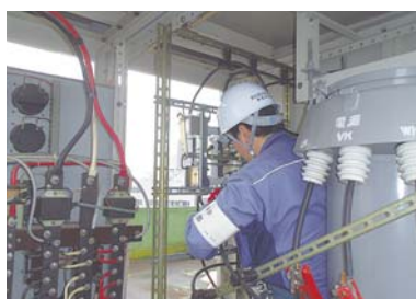
高圧進相コンデンサ取り替え工事
