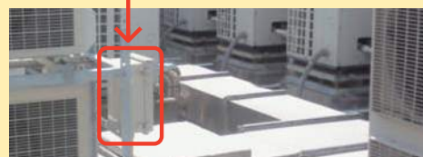
空調自動制御装置(子機)設置例
