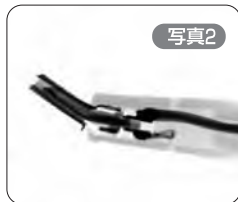
変形したコネクターの内部をみたもの。
