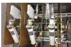
写真5 側面バリア取り付け
