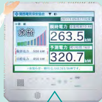
デマンド 監視装置
