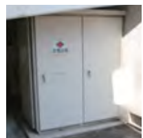
写真1 高圧受電設備 (キュービクル)
