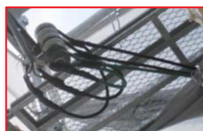
絶縁電線が劣化している場合もあり、特に危険です!!
