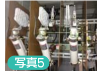
写真5 相間バリアの取付け
