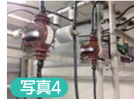
写真4 ターピングによる受電部保護
