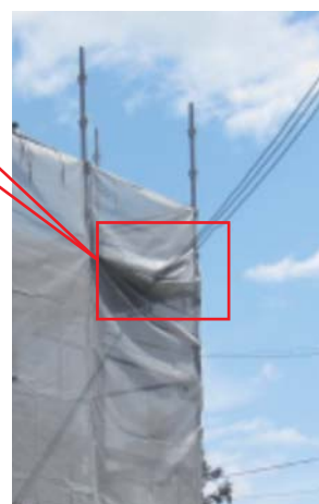
図2 仮設の組立足場に接触した低圧引込線
