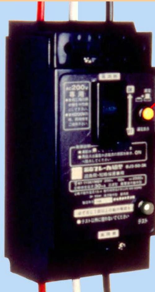
漏電遮断器には、漏電を遮断する機能と、ショートなどの際の大きな電流を遮断するブレーカの機能を一体化したものがあります。動作した時は、電流の流れ過ぎか、漏電の区別をしっかりと確かめて対処することが必要になります。
