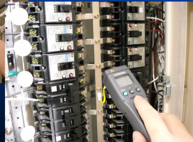
放射温度計による 過熱有無確認
