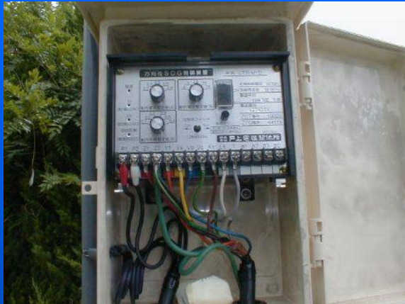
地絡継電器(高圧の漏電検出)
