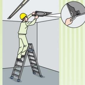
納めた換気扇の差込端子に電線を差込接続するとき、芯線を換気扇のケースに接触させたため、地絡事故となりキュービクル内1階電灯用の漏電遮断器が動作した。
