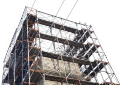
マンション建築工事現場において、足場の鉄パイプが、電力会社の配電線を取り囲むように組まれており、そこで作業していた作業員が、誤って配電線に触れて、感電した。電力会社の配電線に接近する工事であるにもかかわらず、電力会社に連絡せずに作業していた。
