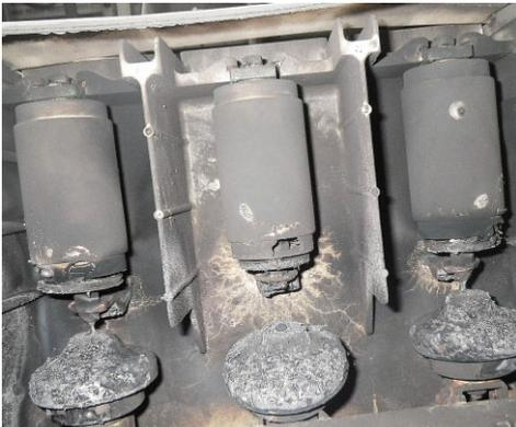
写真3 焼損した真空遮断器内部の状況
