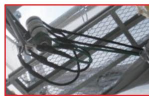
図2 仮設の組立足場に接触した低圧引込線
