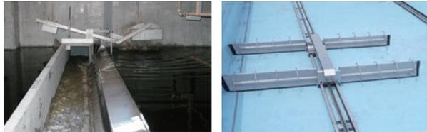
フジフロート自動スカム除去装置 モノレール式汚泥かき寄せ機
