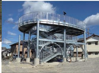
屋根をつけた居室型にする。救助を待つ間の食料や毛布など救難物資をストックする収納ベンチの設置。平常時の防犯を考え、地震のP波や気象庁が発令する津波警報を受信して、タワーの入口を開錠するシステムの開発。ヘリコプターによる救助スペースの設置。高齢者や車いすの方も利用しやすいスロープの設置など。設置環境に応じて柔軟に対応できます。
