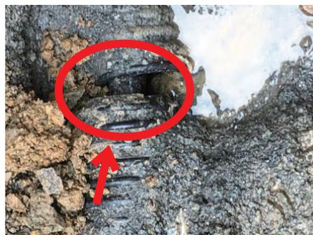
電線管が破れ、高圧ケーブルが露出していた
