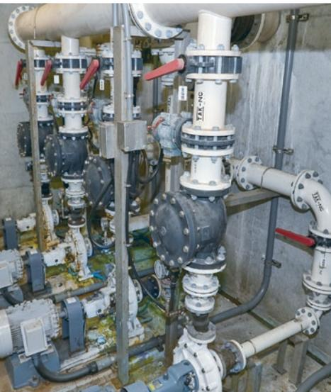
1時間に75kℓの海水をくみ上げる取水ポンプ3基がフル稼働しています。
