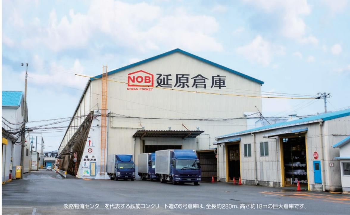
淡路物流センターを代表する鉄筋コンクリート造の5号倉庫は、全長約280m、高さ約18mの巨大倉庫です。
