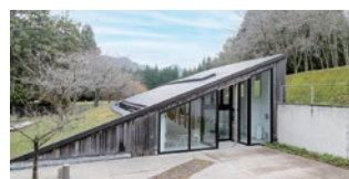
傾斜を利用してつくられた施設棟
