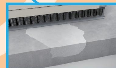
ネズミ、ヘビ、ヤモリなどの小動物が受電設備のなかに侵入すると、高圧充電部に接触して、停電事故を発生させるおそれがあります。キュービクルや電気室の隙間や破損箇所があれば早急に改修しましょう!
