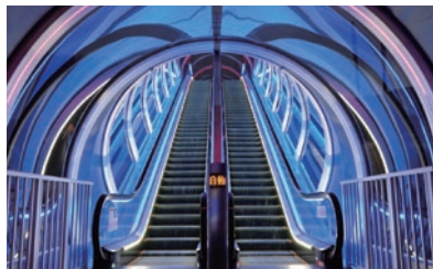
駐車場からゲレンデまでの移動に新設された屋根付きの「最新式エスカレーター（スノーワープ）」。LED照明で夜間も安心・安全です。
