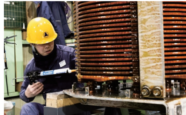
▲コイルにワニスを浸透させた後、接合部に水が入らないようシリコンを塗布します。
