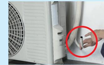
ドレンホースを確認
