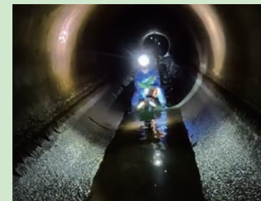
遠隔操作で下水道管の壁面データを取得
